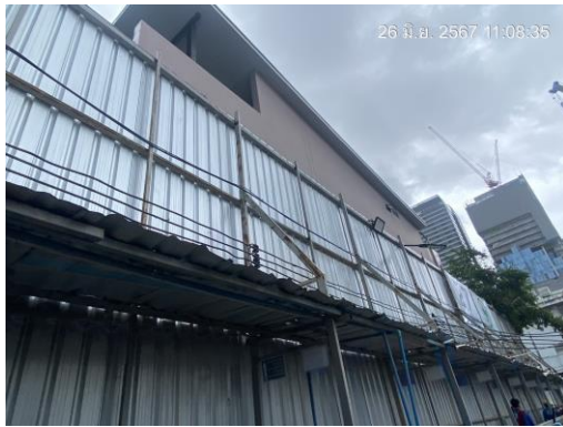
รูปที่ 1 รั้ว Metal Sheet
