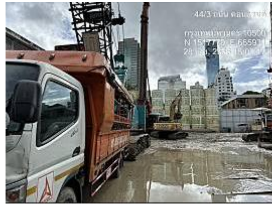
รูปที่ 14 ใช้เสาเข็มแบบเจาะระบบเปียก
