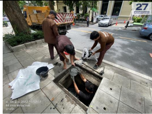
รูปที่ 72 กิจกรรมขุดลอกท่อระบายน้ำ (ต่อ)
