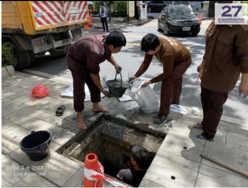
รูปที่ 72 กิจกรรมขุดลอกท่อระบายน้ำ (ต่อ)
