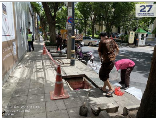
รูปที่ 72 กิจกรรมขุดลอกท่อระบายน้ำ
